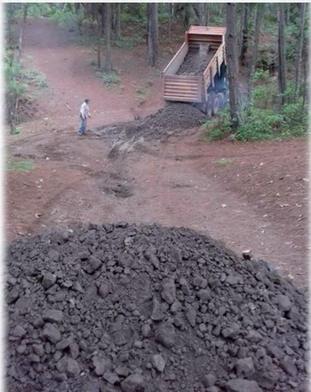
Carga e incorporación de viajes de material inerte (balastre). Carga e incorporación de viajes de material inerte (balastre).
