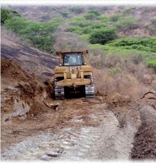
Realizando cortes con tractor D6 para la construcción de brecha saca cosechas con la ntención de optimizar los tiempos de traslados de las cosechas en beneficio de los campesinos.
