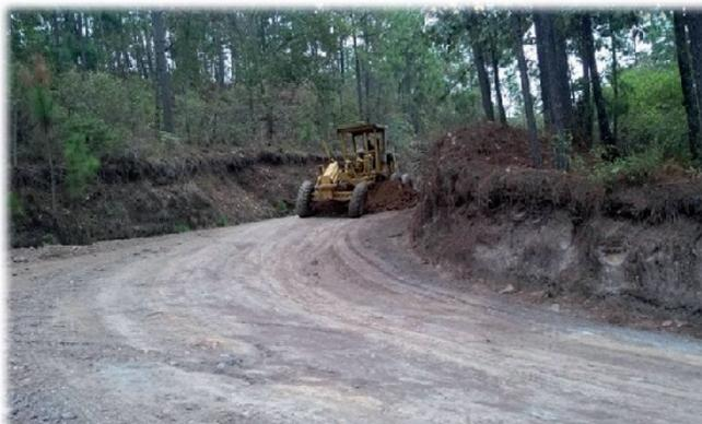
Tendido de material balastre en camino existente para mejoramiento de la superficie de rodamiento.
